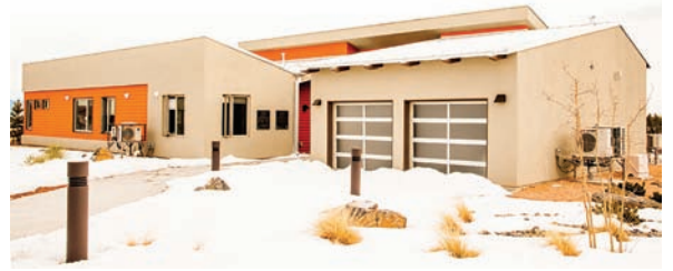
実験に使われたスマートハウス (ロスアラモス)
